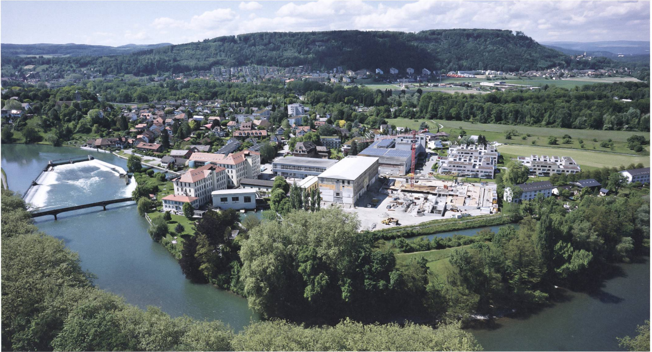
Kunzareal im Umbruch (Bild: Hiag AG)
