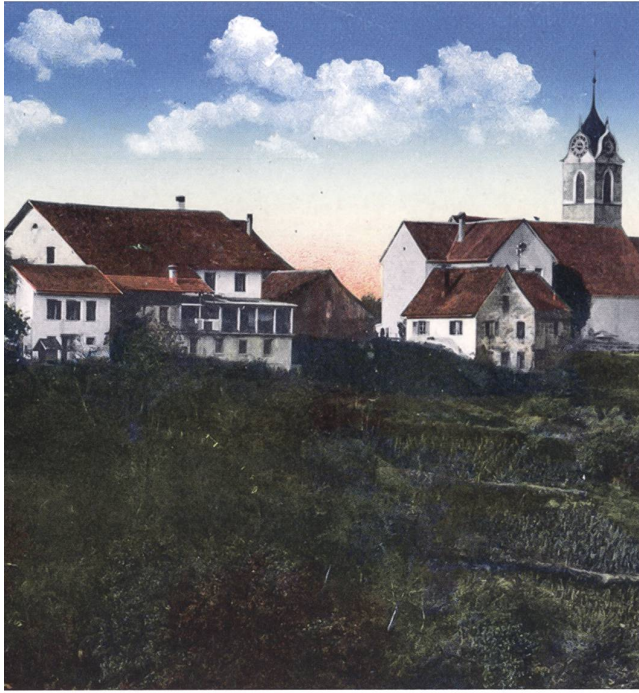
oben, von links nach rechts Ansicht der Liegenschaft Restaurant «Fischerstube» von der Reuss-Seite
