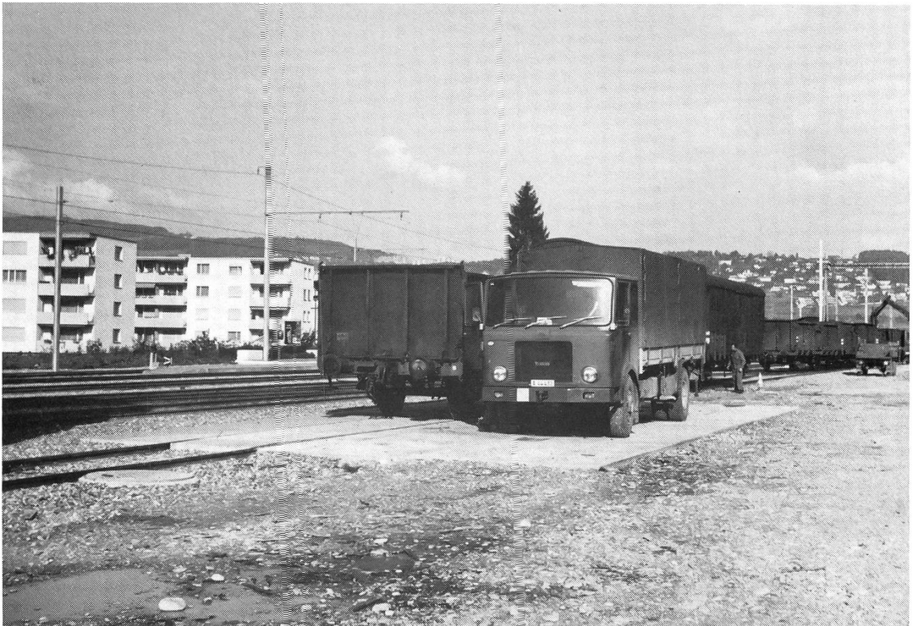
Oel-Benzin Umschlagplatz mit Auffangwanne
