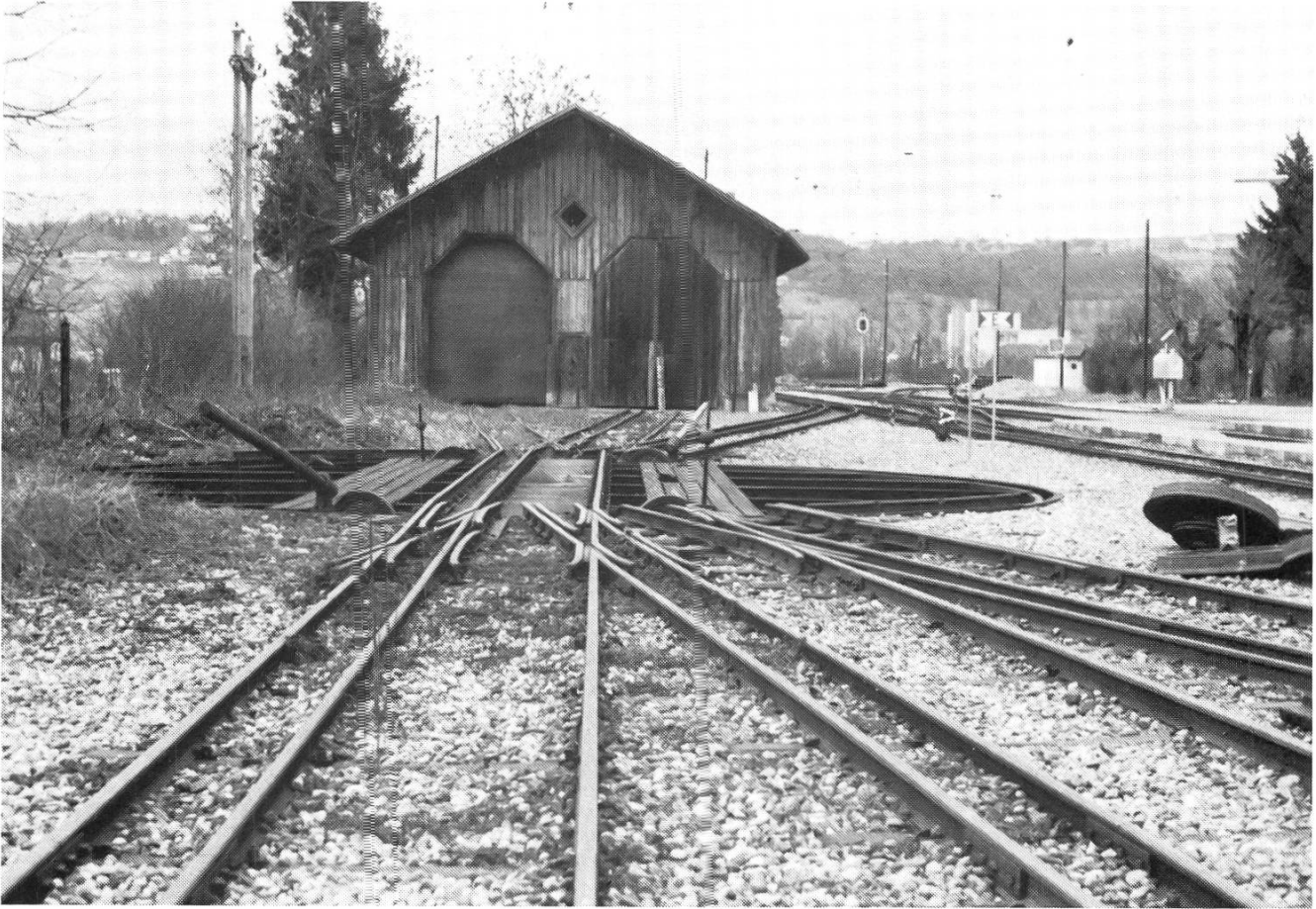
Alte Lok-Remise mit Drehscheibe
