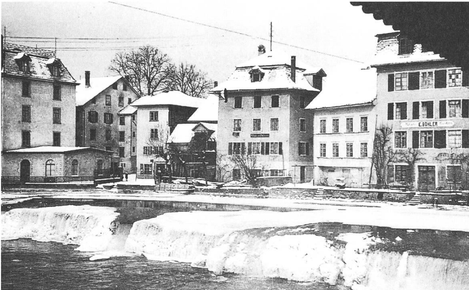
Der rechtsseitige Gewerbekanal gegen die Reussgasse im Banne des Eises.
