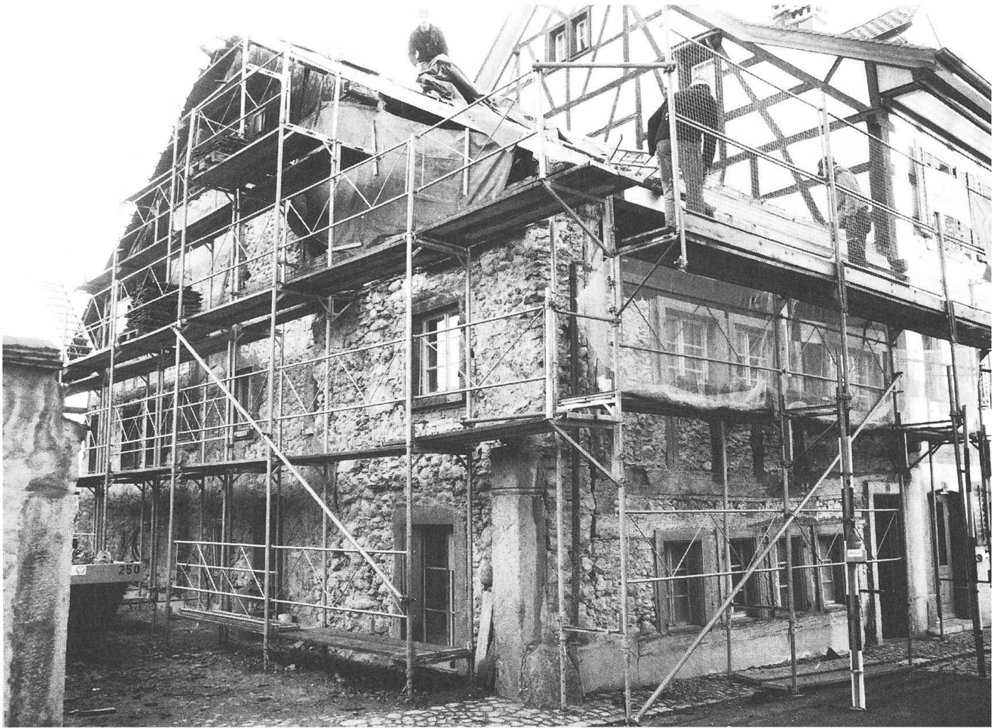
Abb. 3: Ost- und Südfassade (Photo Theo Frey, Kantonsarchäologie)
