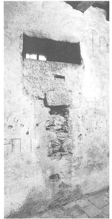
Abb. 5: Fenster an der Westwand des Turmgefängnisses.
