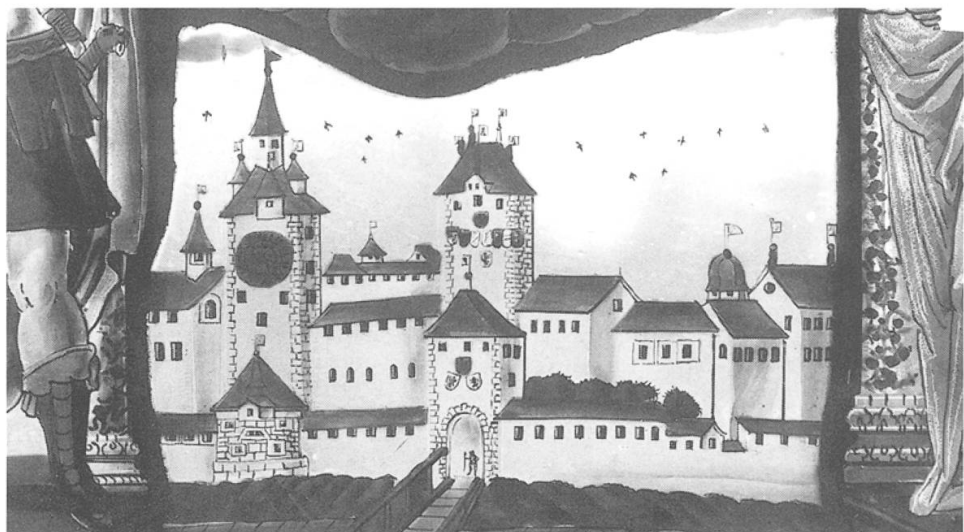
Abb. 1: Ansicht von Bremgarten von Osten. Links der Spittel-, in der Mitte der Platzturm. Stadscheibe von 1677 im Rathaus Bremgarten. (vgl. Text Seite 24)
