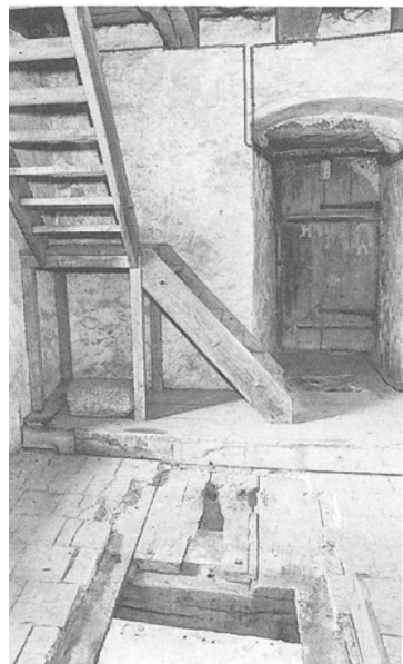
Abb. 8: Spittelturm, 2. OG mit Loch zum Gefängnis und Seilrolle an der Decke. (von Süden, Podest und Treppenverlauf nicht ursprünglich)
