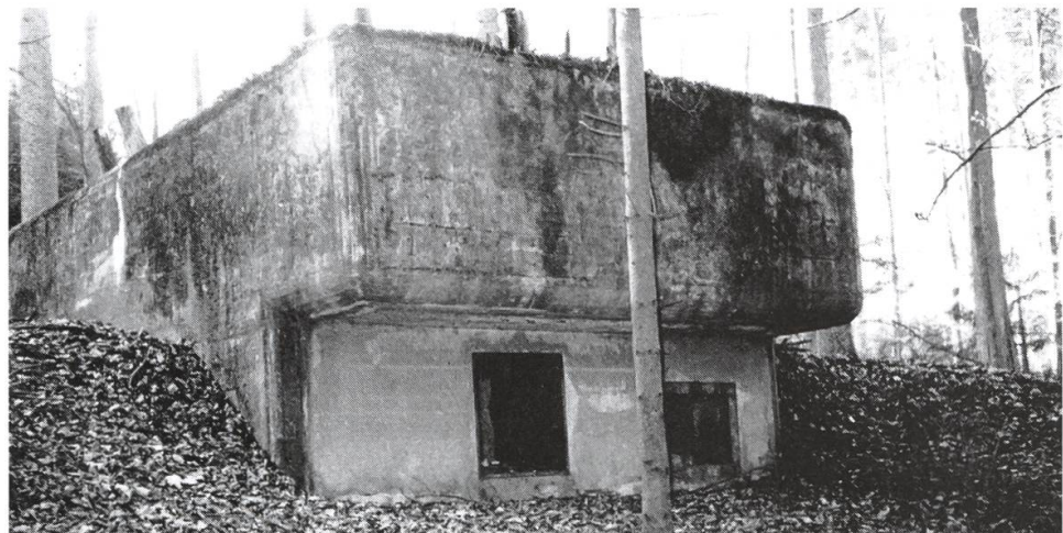
Bunker für 8,4 cm Feldkanone Oberebene/Ripplisberg. Frontscharten für Kanone und Beobachter.
