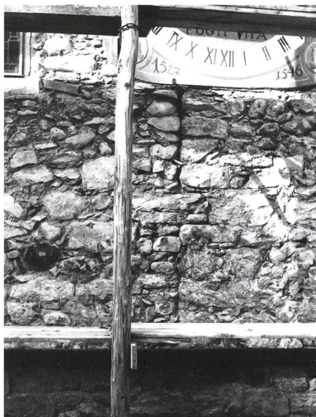
Bei der Renovation von 1982 kam unter dem Verputz auf der Höhe der Sonnenuhr eine Baufuge zum Vorschein. Sie zeigt die Stelle an, ab der die Kapelle um 1676 verlängert worden ist. Foto: Pater Siegfried Müller, Bremgarten.
