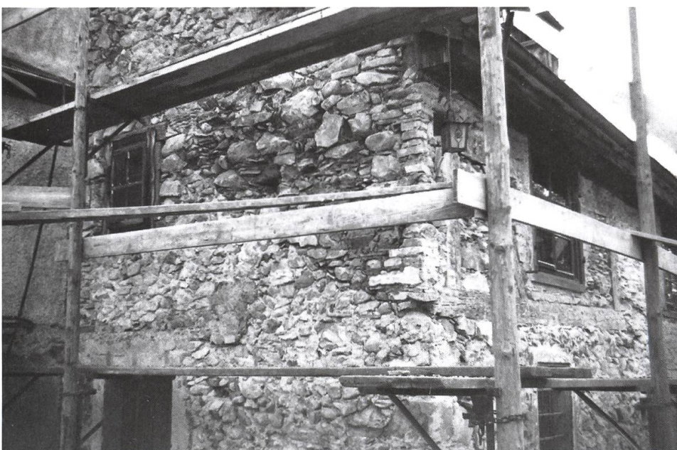
Die schräg-horizontale Baufuge unter dem Verputz über der Sakristei wurde ebenfalls bei den Renovationsarbeiten 1982 entdeckt. Um 1676 war die niedrige Einsiedlerklausen hier aufgestockt worden. Foto: Pater Siegfried Müller, Bremgarten.
