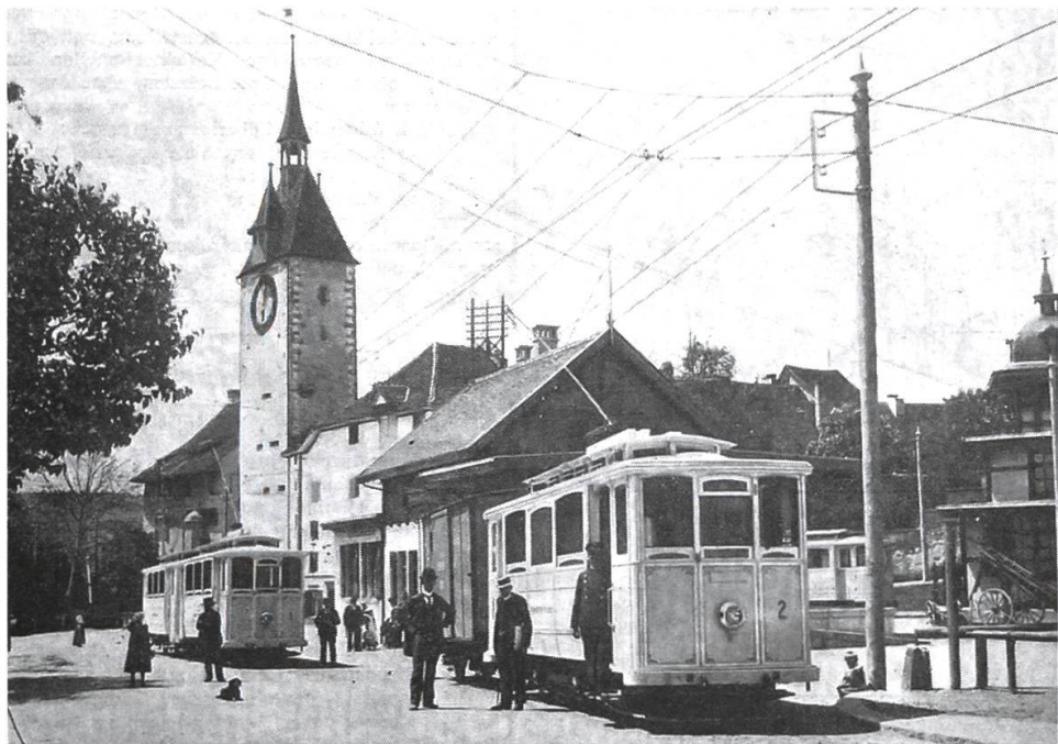
Bahn und Stromversorgungsleitungen beim neuen Bahnhof der BDB um 1902.
