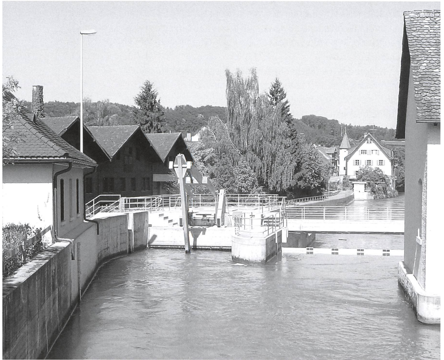
Das Kleinkraftwerk Bruggmühle von der Oberwasserseite.
