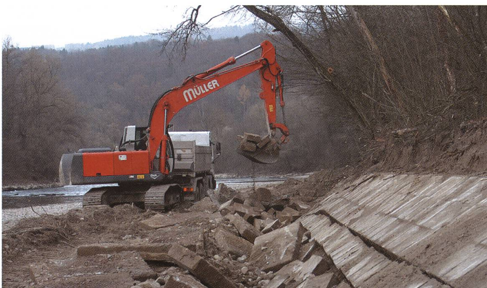
Entfernung der Uferverbauung, die in Reih und Glied gesetzten Betonklötze werden herausgerissen und abtransportiert.
