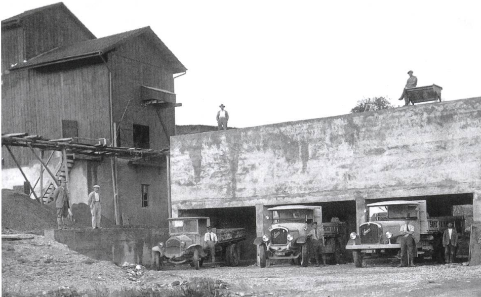
1929: Kieswerk und Verladilos.
