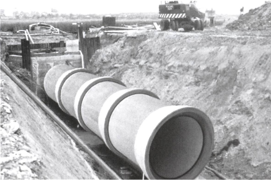
Im Kanalisationsbau wurden die grosskalibrigen SBR-Rohre der Firma Comolli eingesetzt, Durchmesser 150 Zentimeter.
