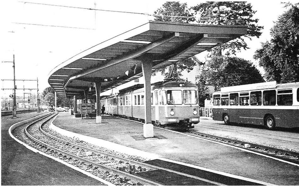
Der neue Bahnhof Dietikon mit zwei Gleisen und Mittelperron.
