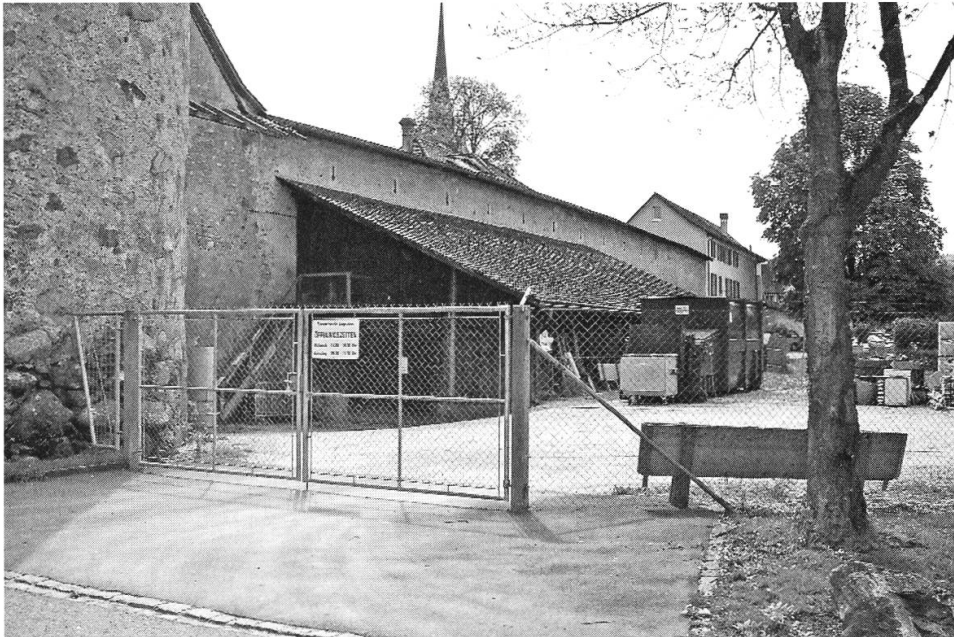
Ehemaliger Holzschof mit Lager Wasserversorgung.
