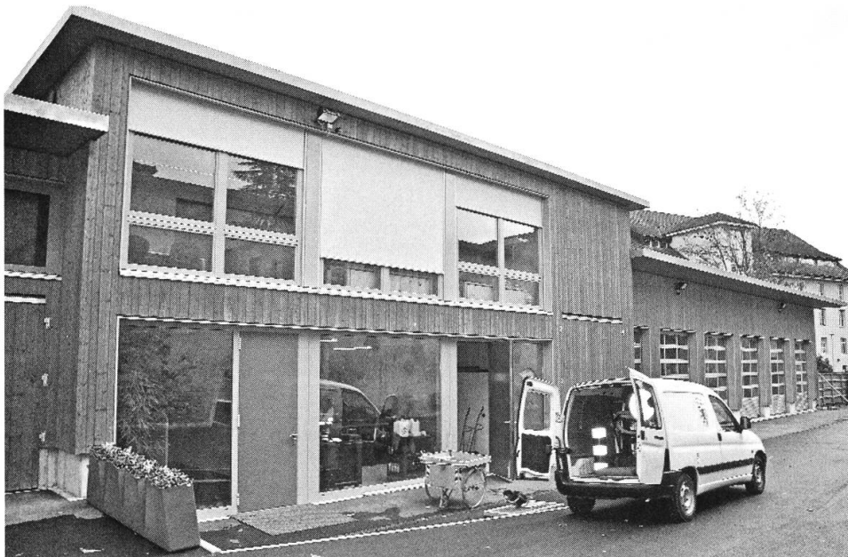
Eingangsbereich zu Büro und Werkstatt sowie Zufahrt zu den Einstellachsen.
