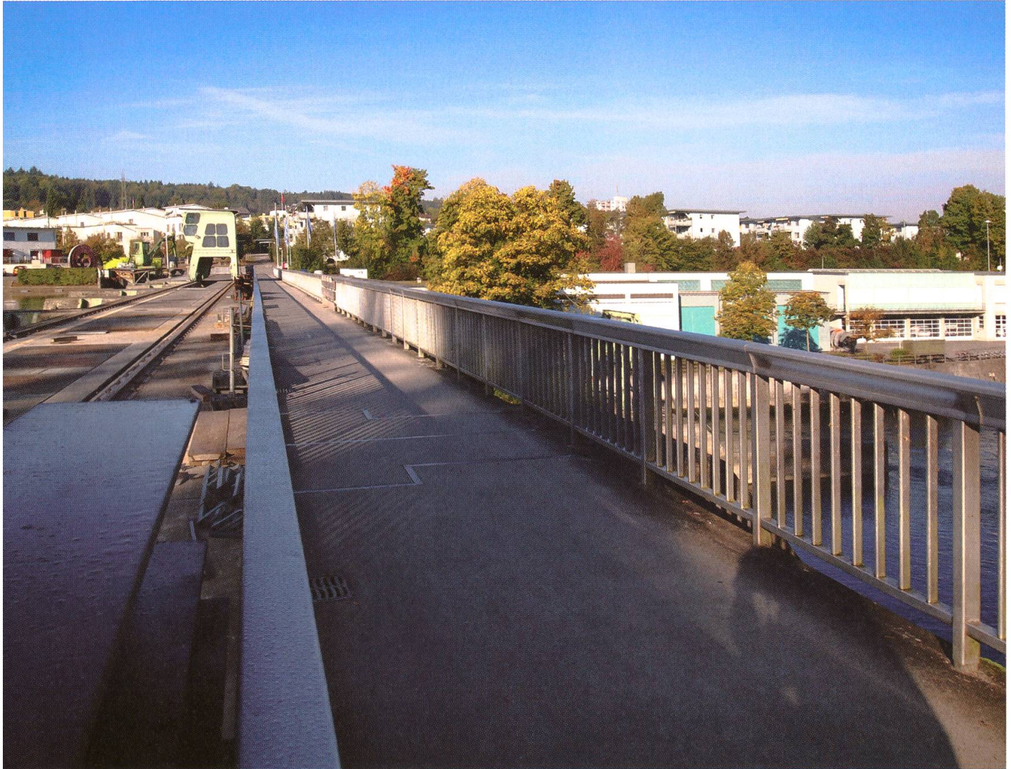
Das Reusskraftwerk Bremgarten-Zufikon mit Fussgängerpassage.
