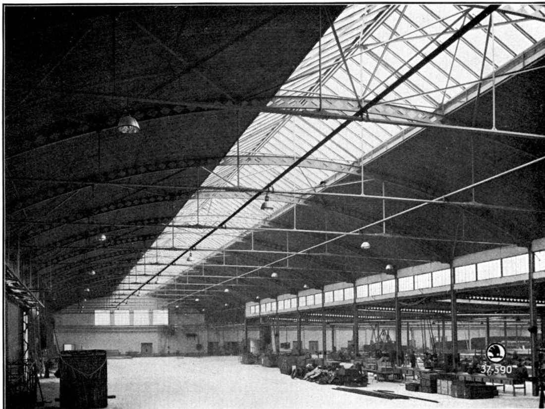
Fig. 1. — Hall de montage pour avions, Parague. Portée des arcs 24 m. Construction entièrement soudée aux ateliers et vissée sur place.
