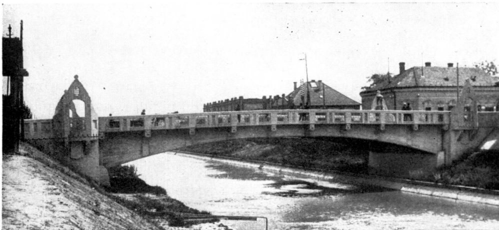
Fig. 8. Pont du Marché au Foin à Témessvár. Heuplatzbrücke in Temesvár. Hay Market Square Bridge in Temesvár.
