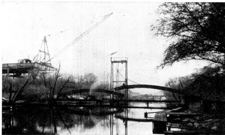
Fig. 14. Pålsund- brücke. Aufrichten der Bogen.
