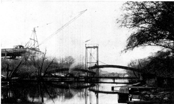
Fig. 14. Pålunds- brücke. Aufrichten der Bogen.
