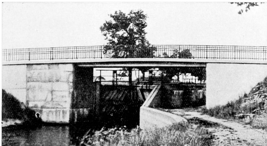
Fig. 10. Pont sur l'écluse n° 4 (Territoire de Belfort).
