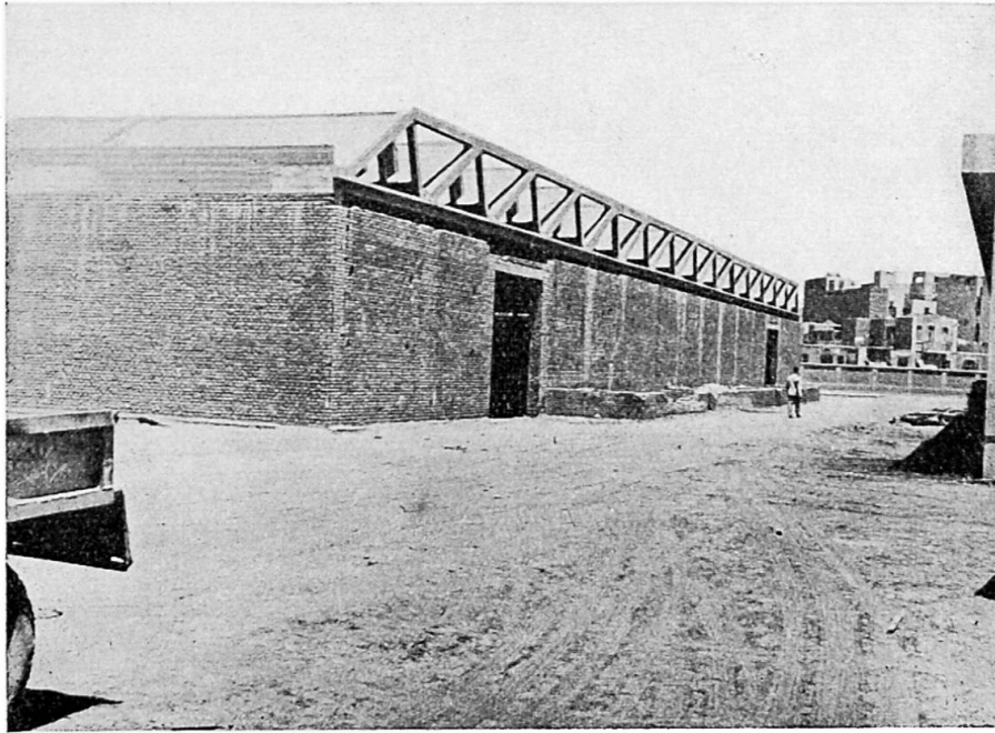
Fig. 7. Vue de la poutre continue sur façade.
