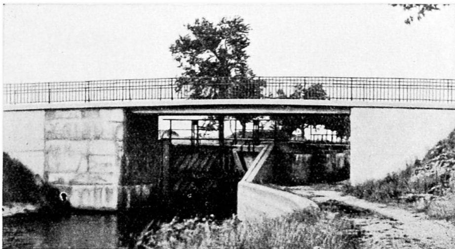
Fig. 10. Pont sur l'écluse n° 4 (Territoire de Belfort).
