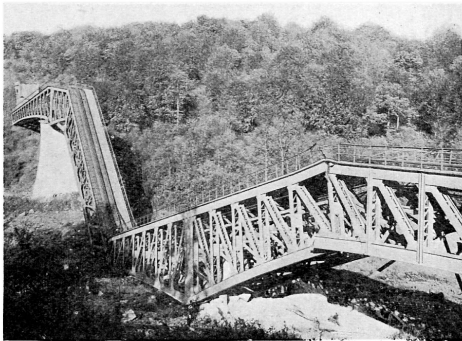
Fig. 6. Viaduc de Serrouville. Destruction—détail de la lère cassure côté Conflans
