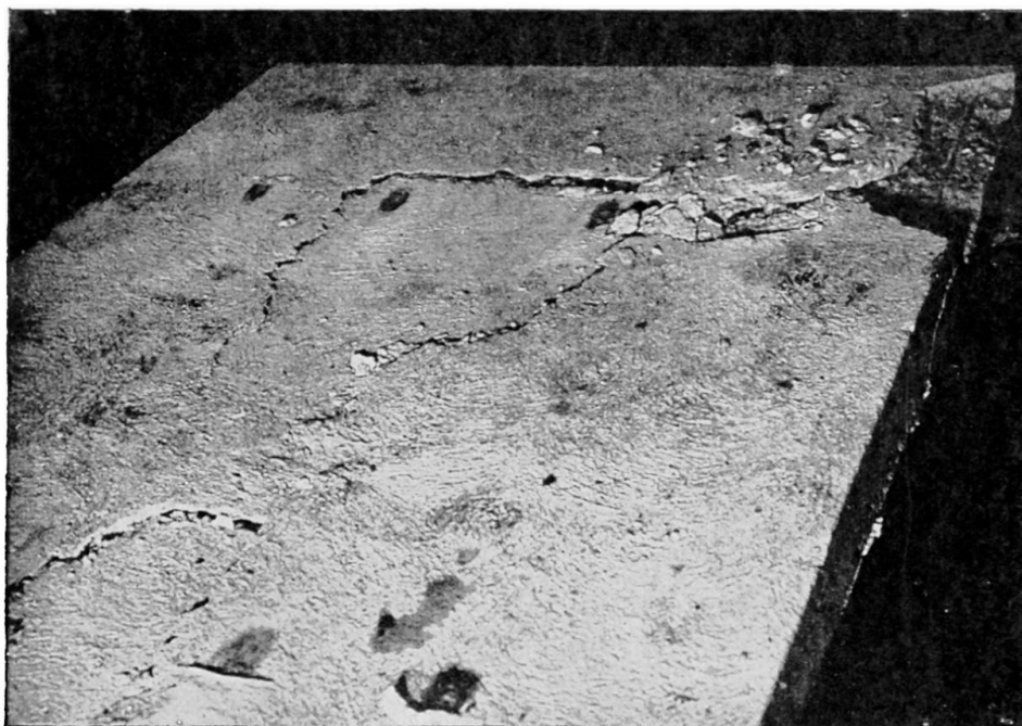
Fig. 14. Rupture en 2ème phase de l'essai à l'effort tranchant du panneau de 9 cm.
