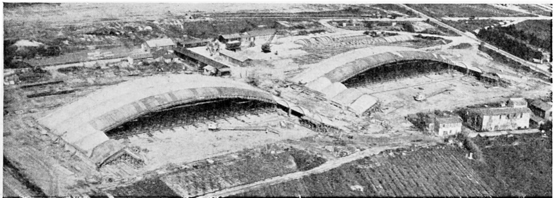
Fig. 26. Vue aeriene en cours de travaux
