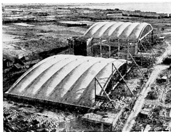
Fig. 33. Début de levage—2ème cellule
