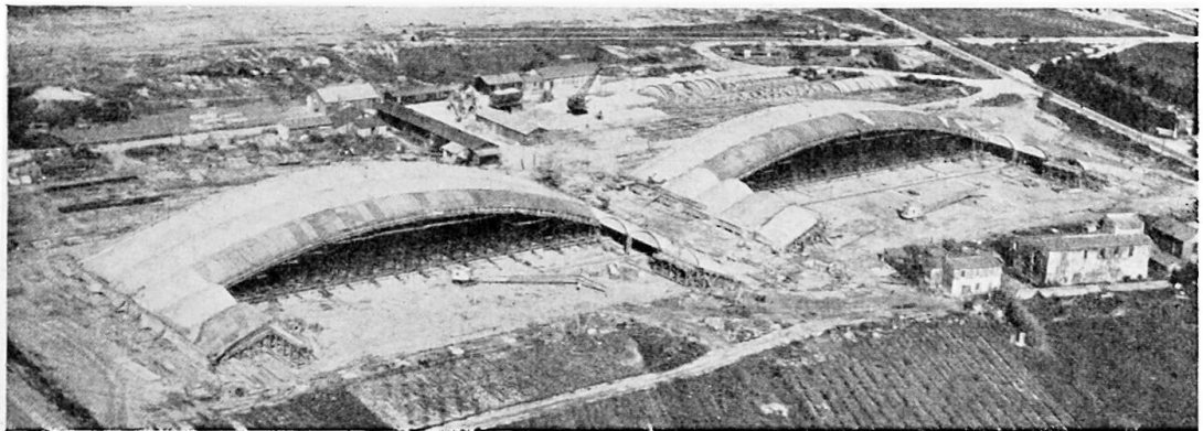
Fig. 26. Vue aerienne en cours de travaux
