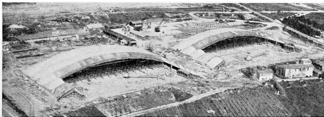
Fig. 26. Vue aerienne en cours de travaux
