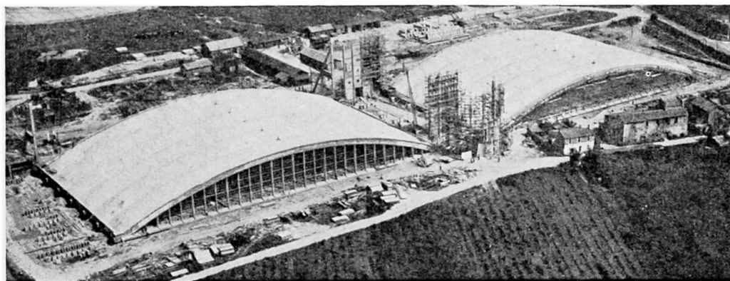
Fig. 27. Couverture prête au levage
