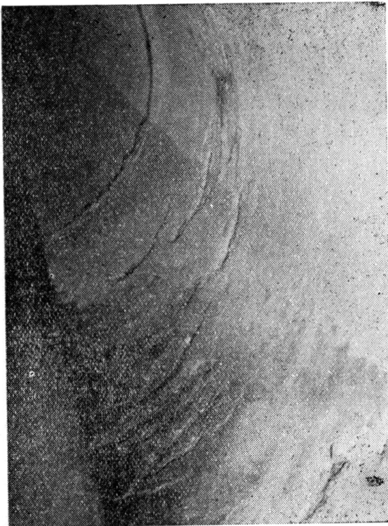
FIG. 5. Les lignes continues du haut de la photographie sont des joints, non des fissures
