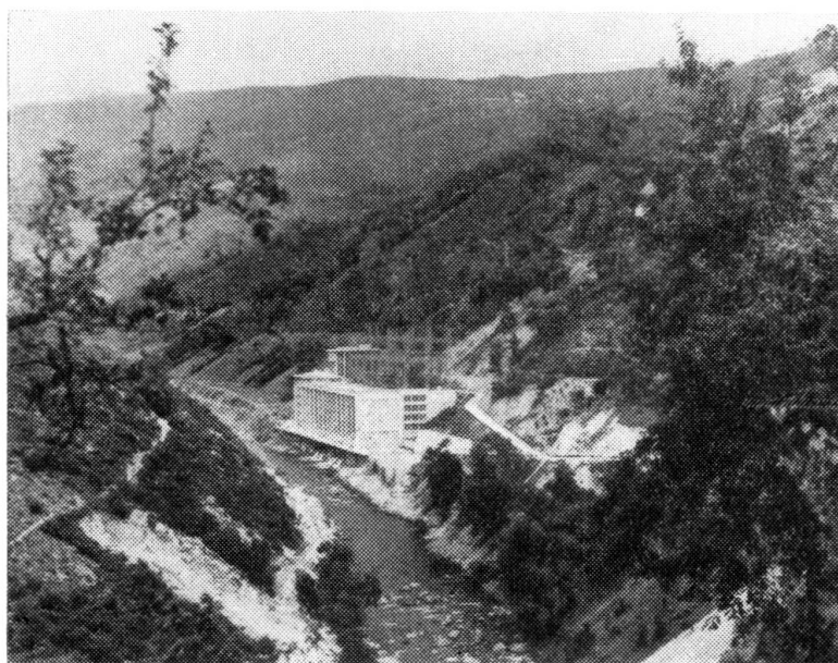
FIG. 23 — Central de Vila Nova
