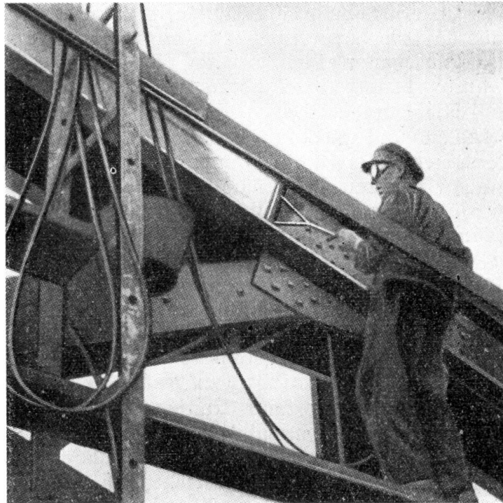
BILD 3. Flammstrahlen einer Brücke. Brennerbreite 300 mm
