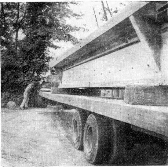
FIG. 3 et 4. Transport de la poutre
