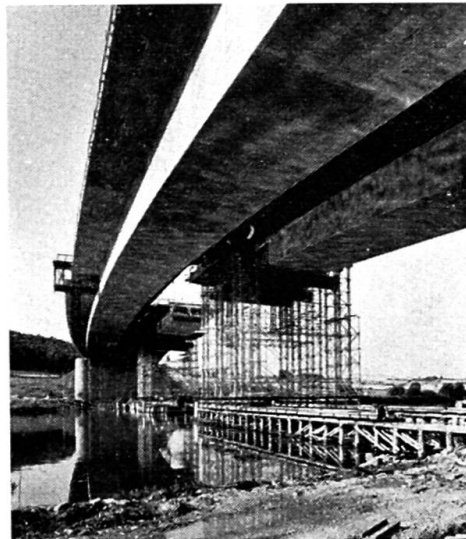
Fig. 6. Brückenuntersicht. Bauzustand. 2. Überbau.
