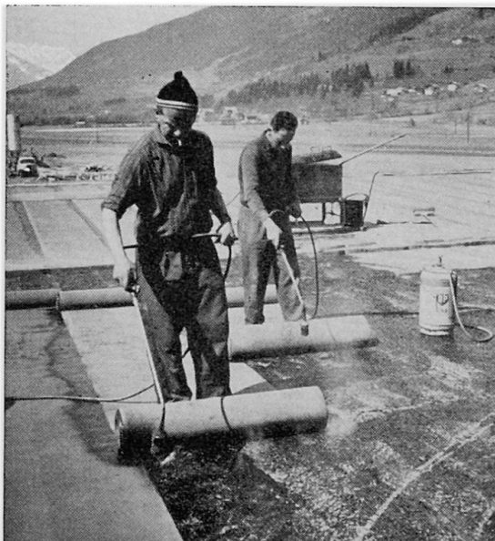
Fig. 1. Bitumen-Isolierungen nach dem Flämmverfahren.
