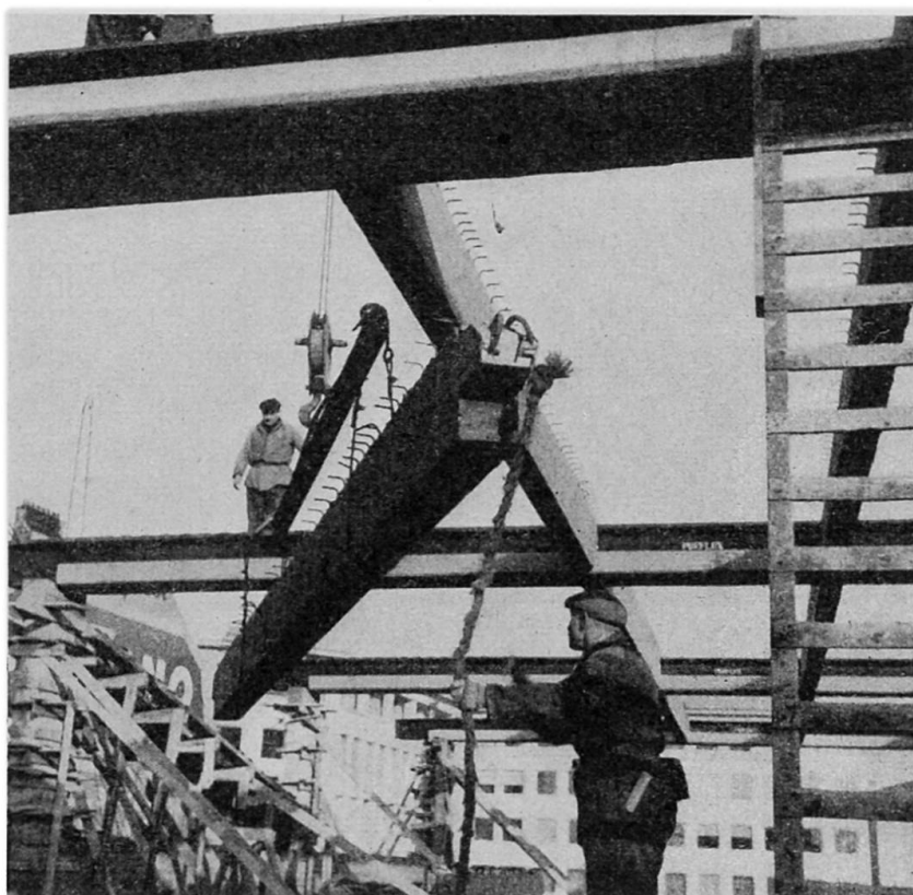
Fig. 6 - Office National du Placement et du Chomage à Bruxelles . Mise en place des poutres préfabriquées en béton armé d'une longueur de 7,50 m sur les poutres Préflex ayant une portée de 15,00 m.
