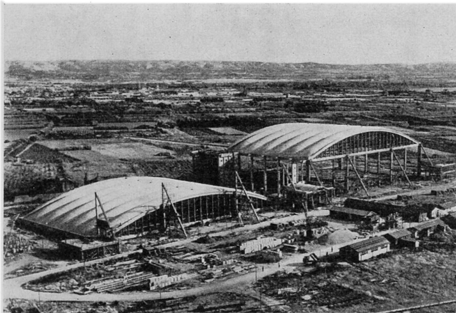
Fig. 29 - Hangar double de Marignane. Voûtes pesant 4200 t levées à 19 m.
