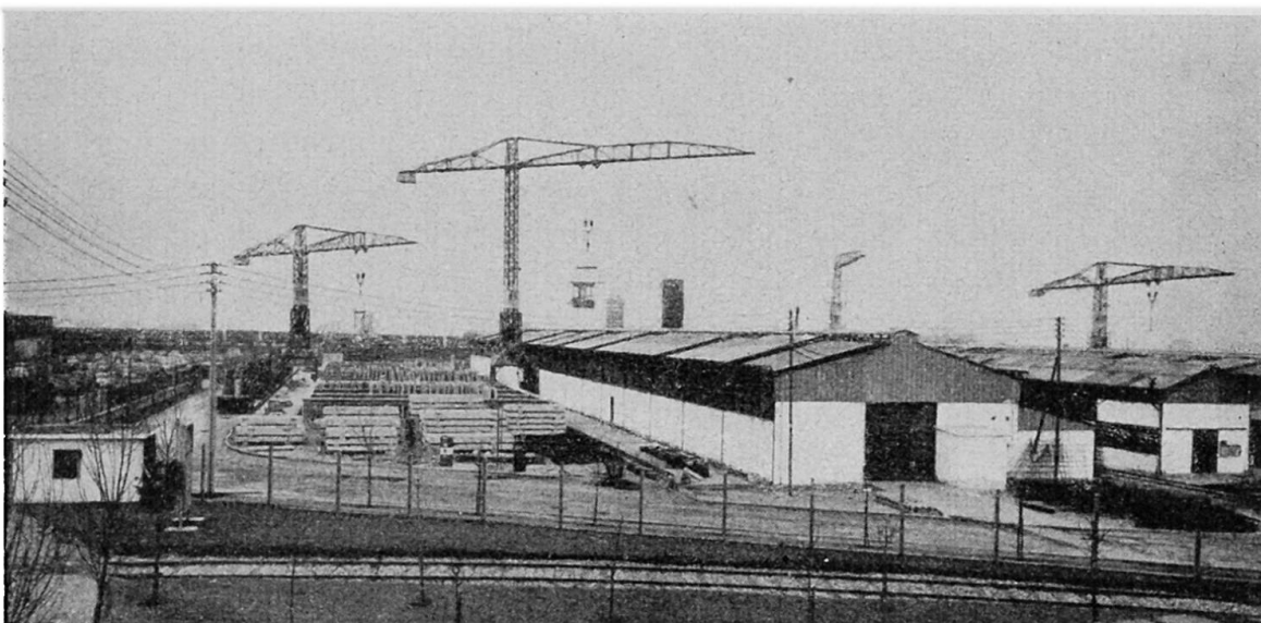
Fig. 5 - Usine de préfabrication à Villeneuve le Roi (1957) comportant des toits ouvrants et desservie par des grues (Balency).
