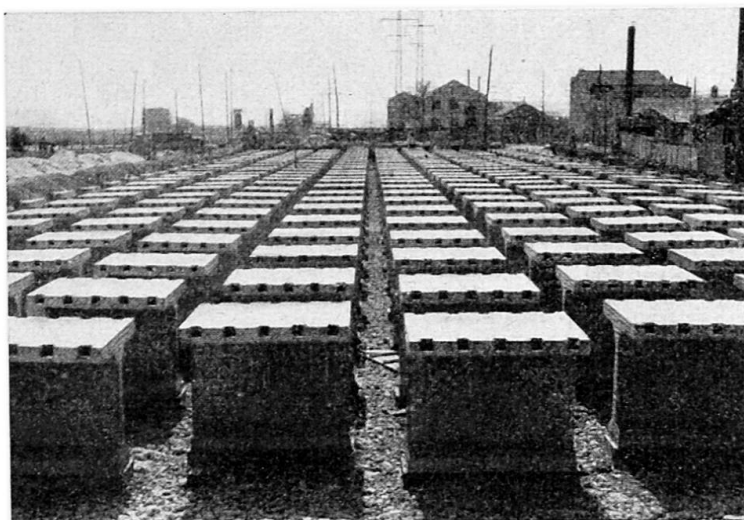
Fig. 10 - Park de stockage des douelles pour la gâre souterraine de Barcelona.
