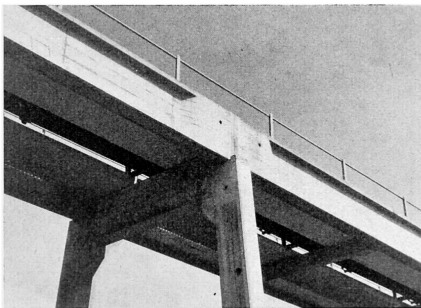
Abb. 12 - Detail der Stabbogenbrücke (Abb. 11). Deutlich erkennbar sind die profilierten Stützen und Sekundärträger. Der Querträger wurde mittels Durchschubkabeln System BBRV angeschlossen.
