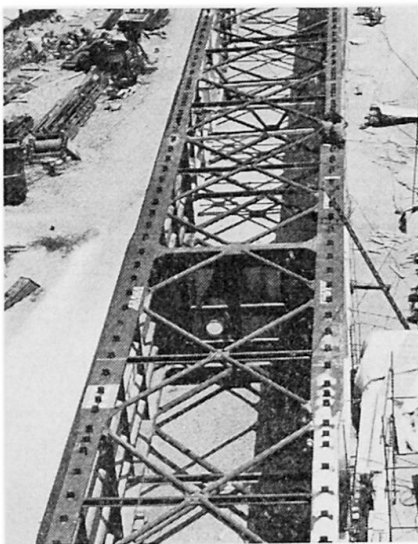
Fig. 3. Tronçons sur pile en montage.
