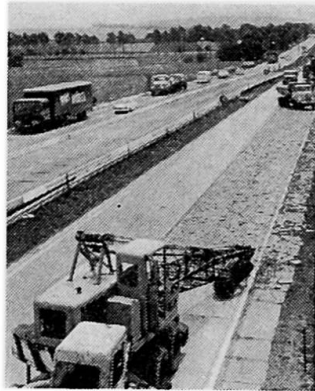
Fig. 3. Stahlfachstraße neben der Reparaturstrecke auf der Europastraße 4 Frankfurt-Hannover.
