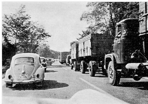
Fig. 2. Fahrzeugstauung vor einer deutschen Autobahnreparaturbaustelle, wenn der vier-spurige Fahrverkehr auf zwei Spuren eingeengt wird.
