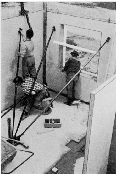
Fig. 10. Montagehalterung nach O. PLATZER (Berlin) (Pat. ang.) [8].
