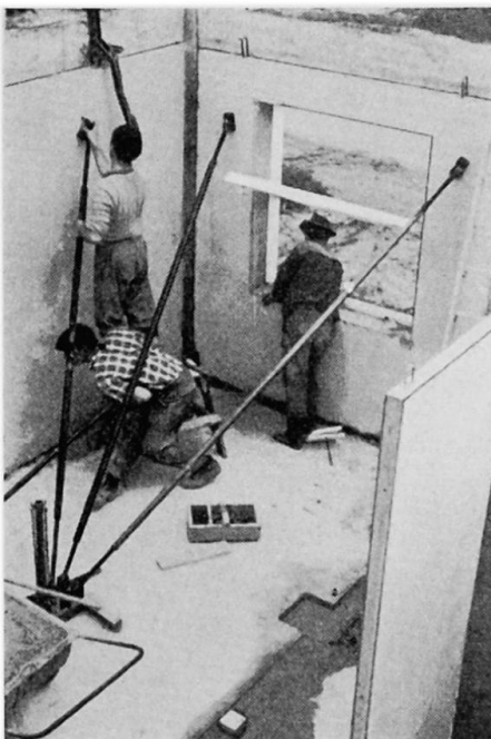
Fig. 10. Montagehalterung nach O. PLATZER (Berlin) (Pat. ang.) [8].
