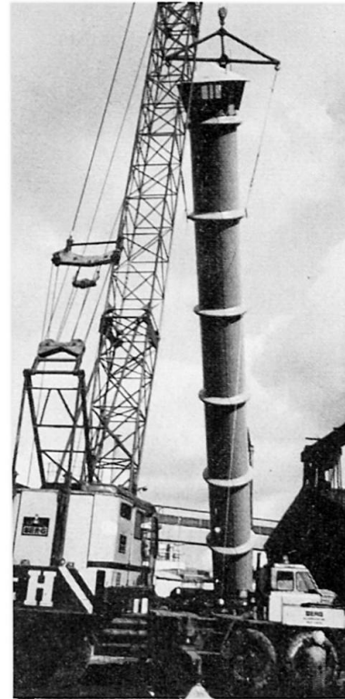
Montage des GFK-Ansaugkamines, Abb. 11
