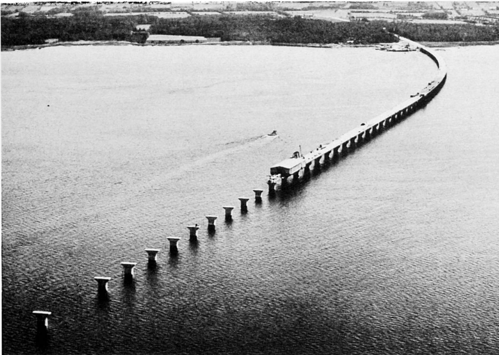
Das Vorschubgerüst auf der Ölandseite
