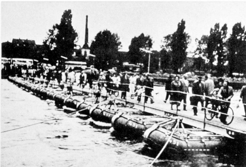
Abb.2 zeigt eine Aluminium-Schlauchboot-Brücke, bei der durchlaufende gekoppelte Aluminium-Träger auf schlauchbootartigen Pontons gelagert sind.
