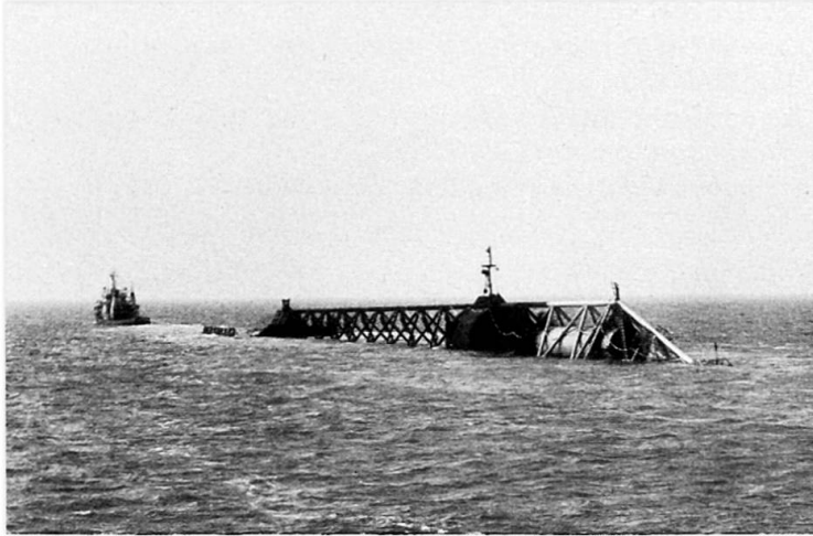
Figure 1 - Colonne articulée en cours de remorquage
