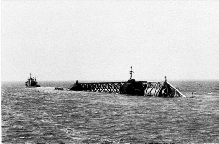
Figure 1 - Colonne articulée en cours de remorquage
