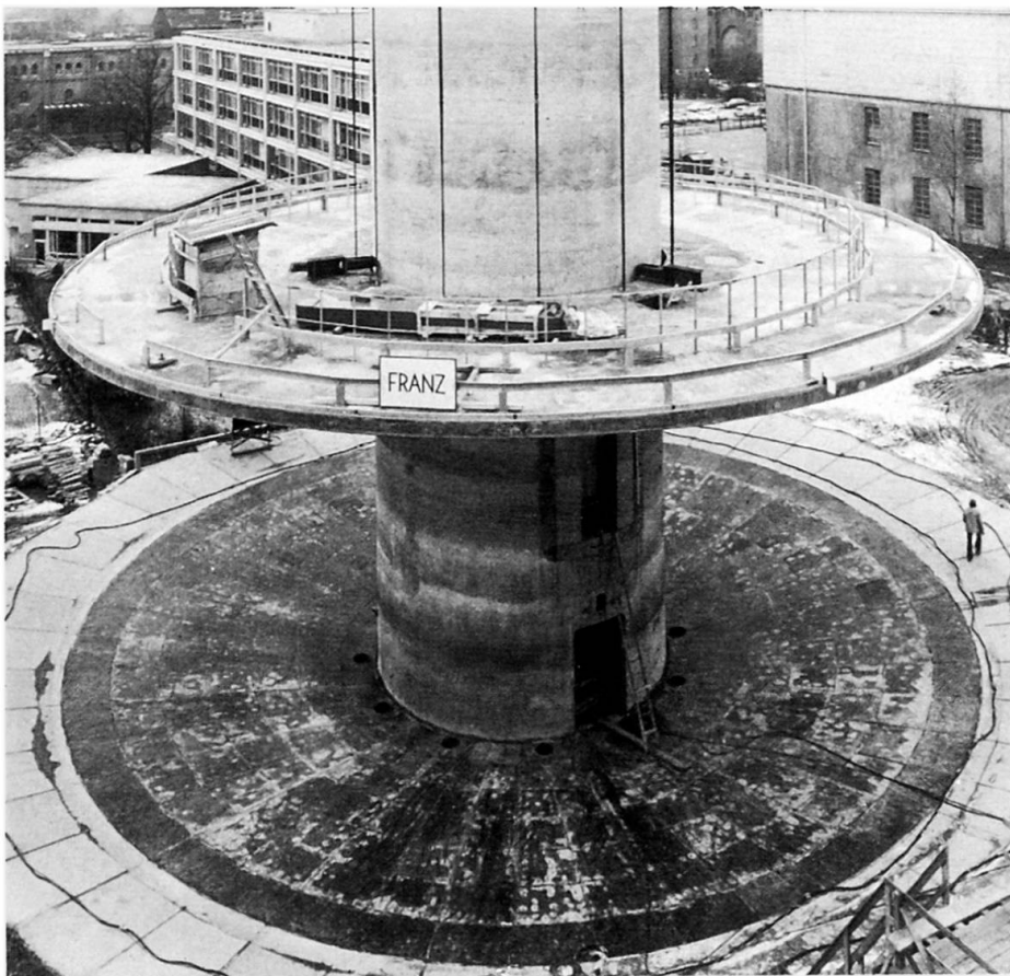
ANHEBEN DER PLATTFORMEN BEIM RICHTFUNKTURM ARSENAL
