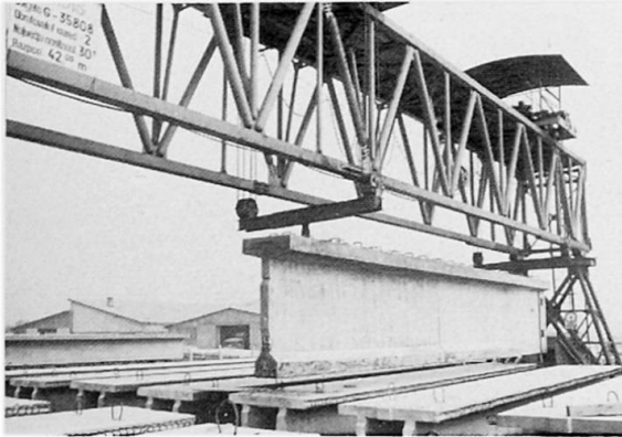
Bild 5: Trägerdepo im Betonwerk
