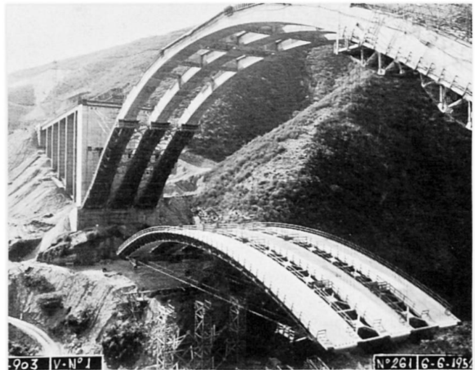
Un des viaducs de Caracas.
