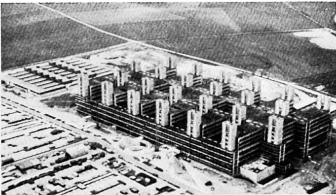
Bild 1. Neubauten des Klinikums Aachen im Ausbauzustand
