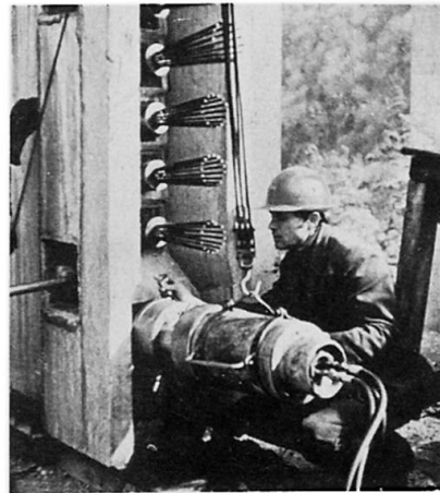
Bild 9: Vorspannen von IMS Vorspannkabels
