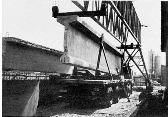
Bild 6: Trägeraufladung auf Transportmittel
