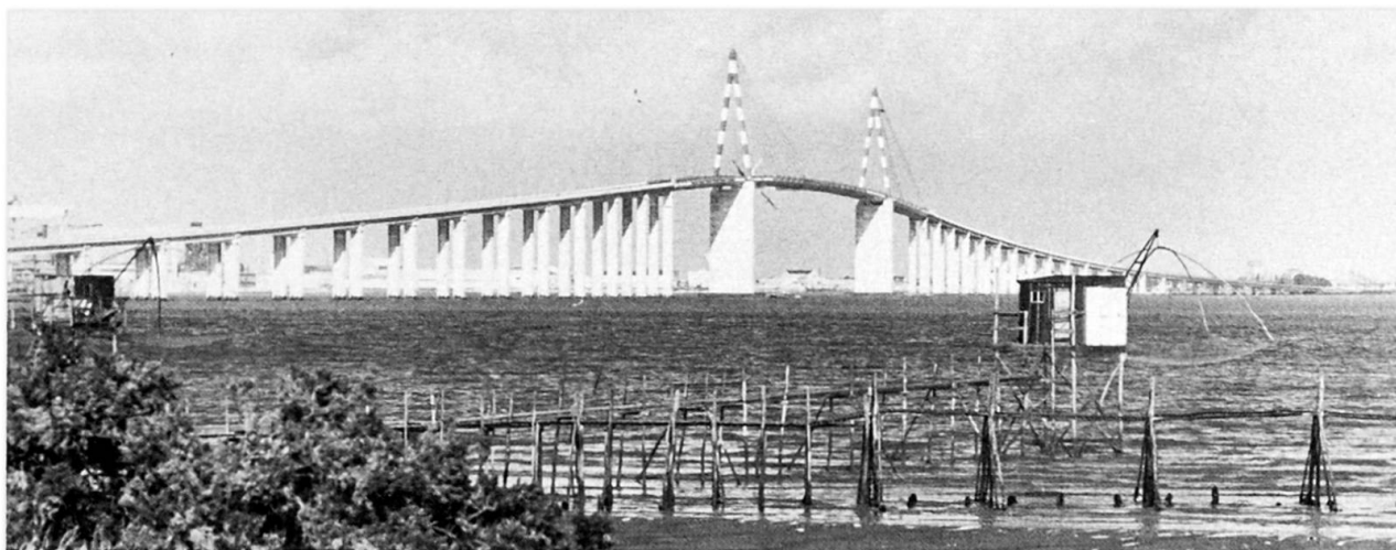
Figure 1 - Pont de SAINT-NAZAIRE
