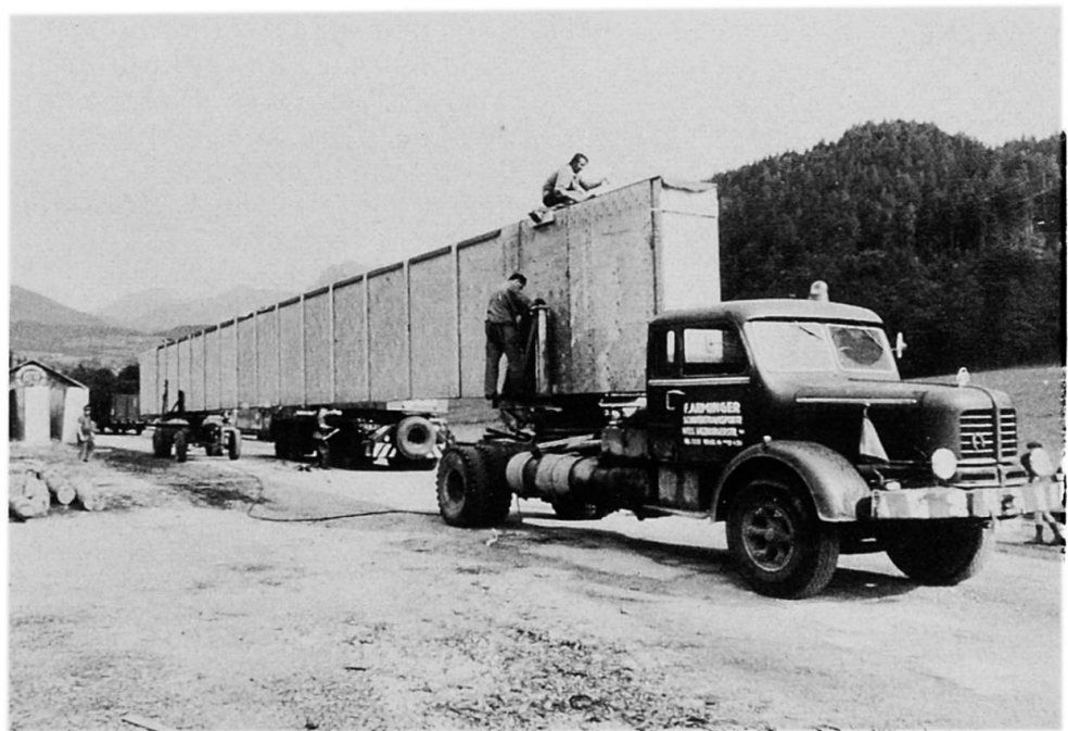
Bild 10: Straßentransport von 32 m langen Kastenträgern mit Sperrholzstegen
